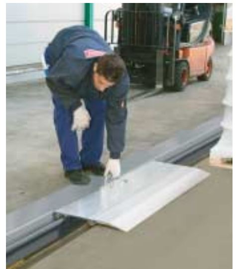
Sicheres Befahren der BB – Brücke.
