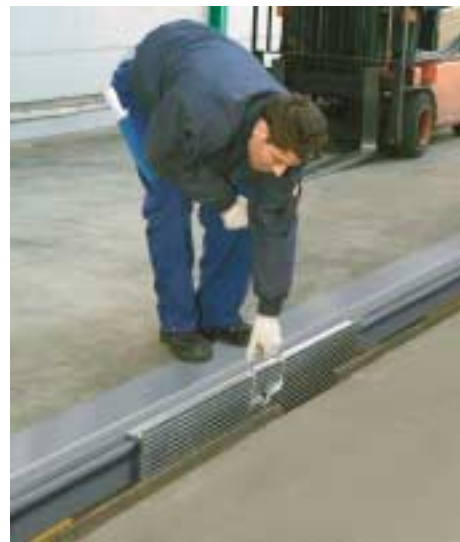
BB-Brücke aus der Führungsschiene herausheben.
